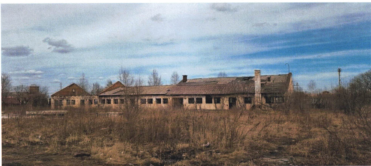
Фотография 3 (28:05:010534:55 - разрушенное здание в границах КРТ 602)
